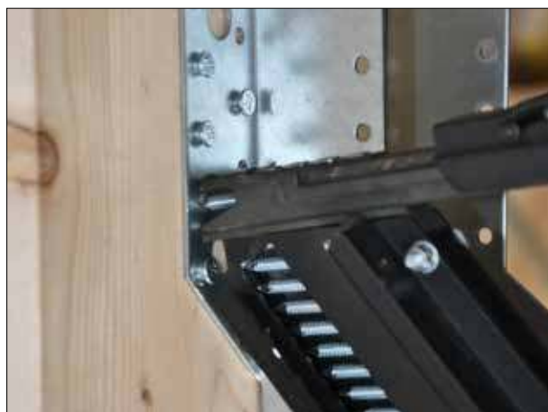
Suporte SAE instalado com CNAPC34
