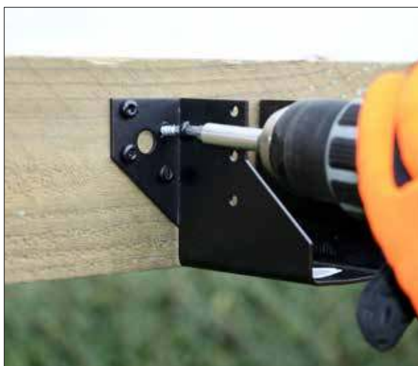
Suporte SAE-PB preto instalado com parafusos CSA-PB
